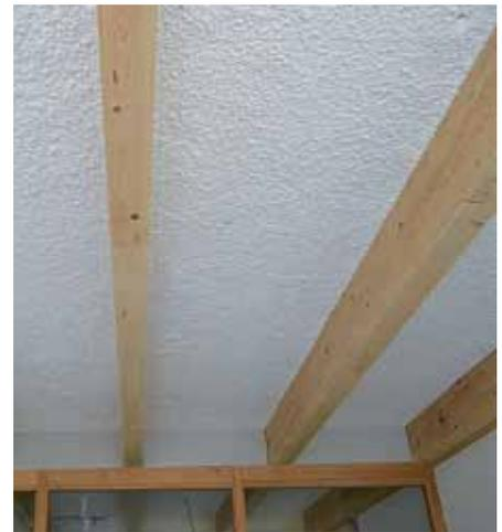
ISOAKUST kann auf viele gut vorbereitete Flächen gesprayed werden (Holz, Beton, Putz/Gipskarton, Stahl, Glas usw.). Sorgfältig verklebte Flächen definieren den zu sprayenden Bereich.
